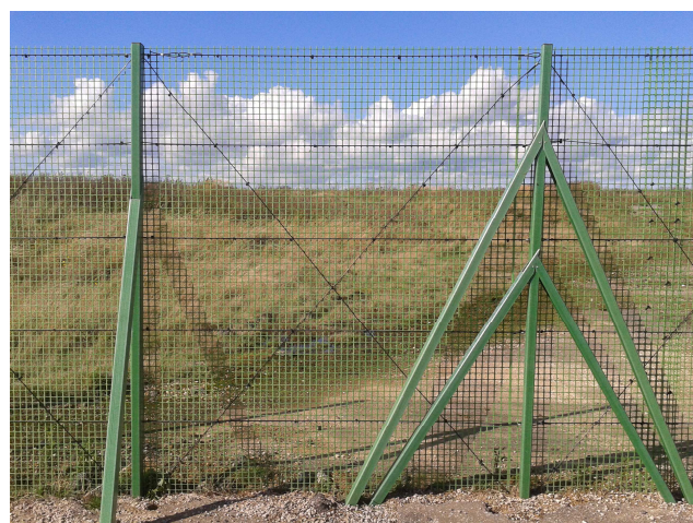
Source : DSAC. Clôture amagnétique, poteaux de soutènement plastiques avec jambe de force, maille rigide dure, enfouie au sol pour prévenir les intrusions animales, entretenue et dégagée de toute végétation
