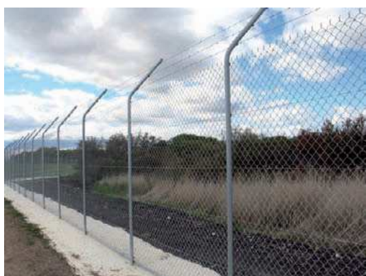
Clôtures avec bavolet et enfouissement du grillage dans du béton Source : STAC
